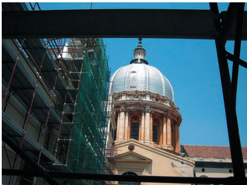
La réhabilitation du patrimoine bâti a un grand impact sur l'économie locale, tant du point de vue des emplois créés que du niveau de revenu des ménages – Naples, Italie.
