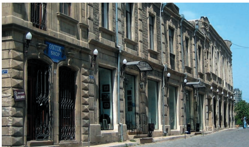
Le patrimoine bâti est souvent un lieu d'accueil idéal pour de petites entreprises – Bakou, Azerbaïdjan.
