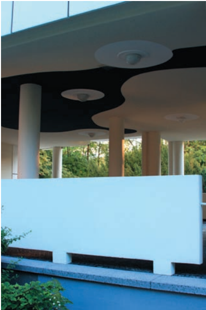
Alvar Aalto (Finlande), partie centrale de la maison sur pilotis. La peinture décorative au plafond, créée par Aalto, a été récemment restaurée.
